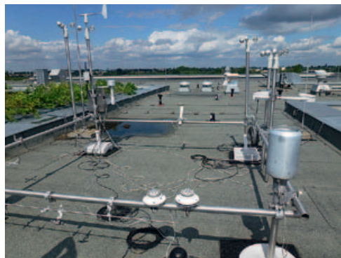
Flachdach mit Mecoprop-haltiger Dachhaut und Wetterstation
